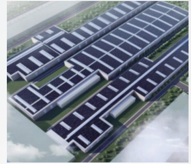
仅一期厂房屋顶光伏发电 (按25年计算)
